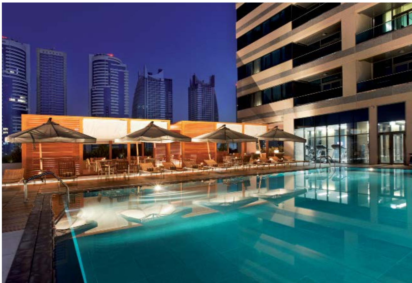
"VQ Ventiquattro Radosson SAS Residence" - Dubai Marina - UAE
